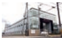
本社及び配送センター
