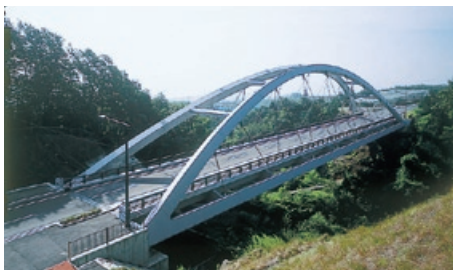
鋼製橋梁の製造・架設
