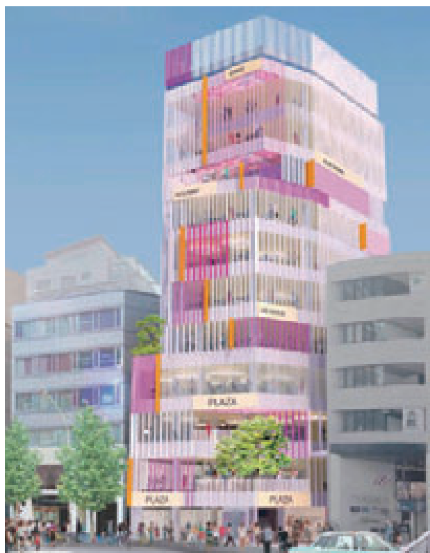
解体工事着手済み 開業：平成27年春(予定)
