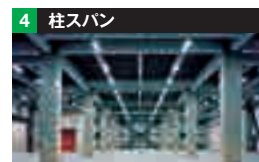
庫内作業・保管の効率を高める最大20mの柱スパン
