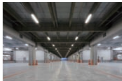
施設中央に配置された車路
