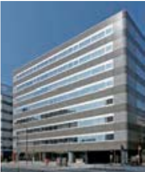
アーバンネット三田ビル 東京都港区三田
