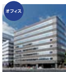
アーバンネット 三田ビル
