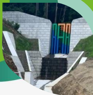
砂防関係施設整備
